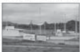
Construção de Centro Esportivo Sta. Gertrudes
