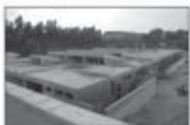
Construção de creche no Morada das Vinhas e no Jardim Tulipas
