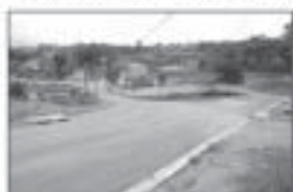
Pavimentação da Avenida Emma Gossner - Ivoturucaia
