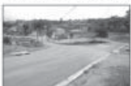
Pavimentação da Avenida Emma Gossner - Iboturucua
