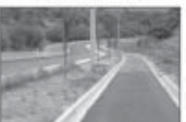
Duplicação da Av. Antonio Pincinato e construção de ciclovia
