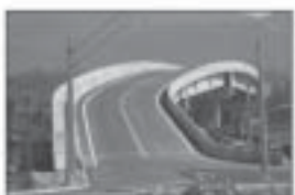
Obras do entorno do Complexo Viário Xisto Cereser (Ibovo de Ita)
