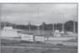
Construção de Centro Esportivo Sta. Gertrudes
