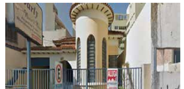
Fachada principal – fonte: Google Street View, acesso em 01.02.2016.
