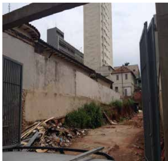
Terreno lateral – aclave do terreno onde está construída a casa.
