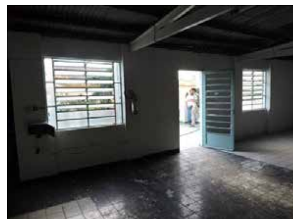
Portas e janelas substituídas posteriormente.
