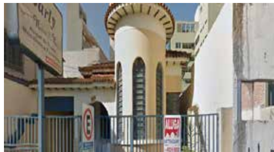
Fachada principal – fonte: Google Street View, acesso em 01.02.2016.
