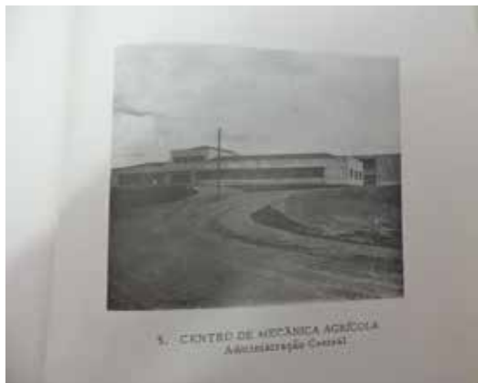
Foto 1: Sede administrativa no período de sua construção. FONTE: Própria, 2016.
