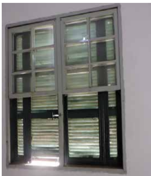
Foto 26: Esquadrias de madeira das janelas. FONTE: Própria, 2016.
