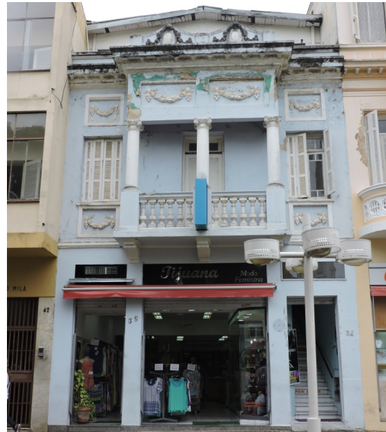
Foto 1: Imóvel à Praça Pedro de Toledo, 34-38. Diretoria de Patrimônio Histórico, 2016.
