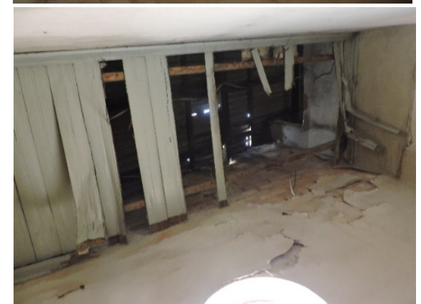
Forro de madeira.
