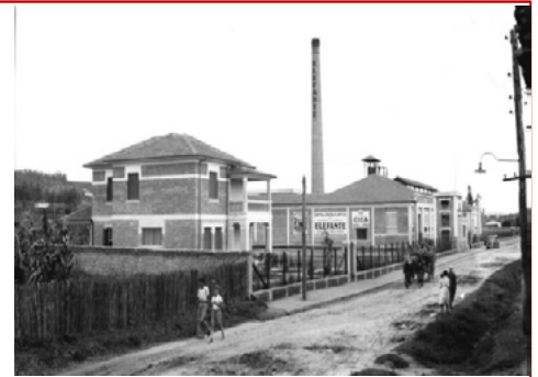
Figura 19 - Primeiras construções da CICA: Parte da casa Bonfiglioli, parte do primeiro galpão e chaminé. 1942. Fonte: Centro de Memória de Jundiaí
