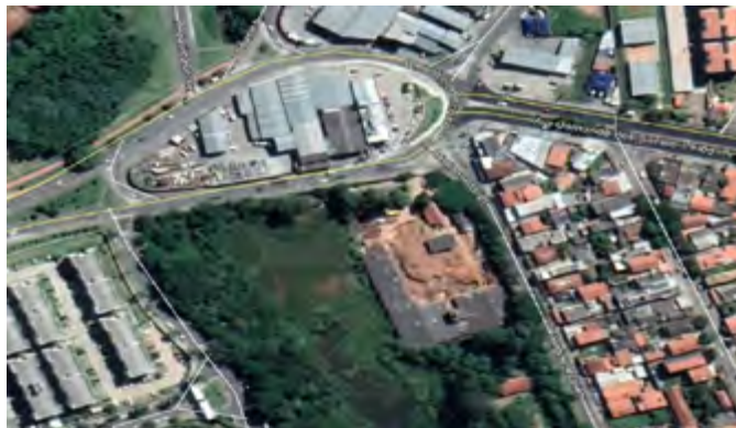
Imagem 04 – Trecho – Implantação de sinalização
