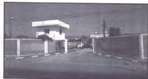
FOTO 01 - Vista frontal - Av. 14 de Dezembro
