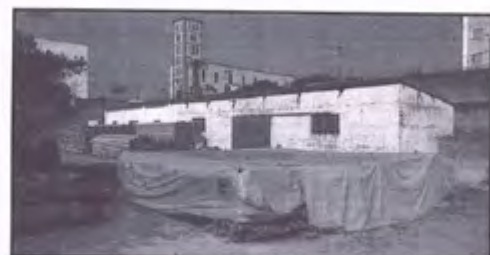
FOTO 02 - Vista do Barracão
