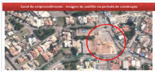
Imagem 01 – Vista do empreendimento na fase de construção
