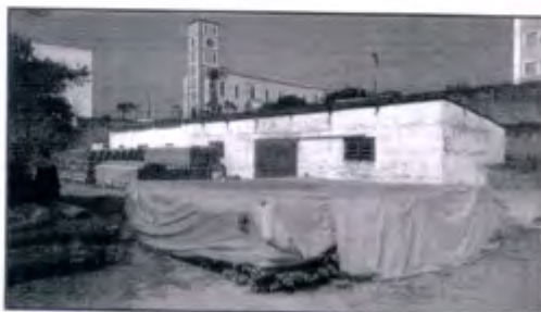
FOTO 02 - Vista do Barracão
