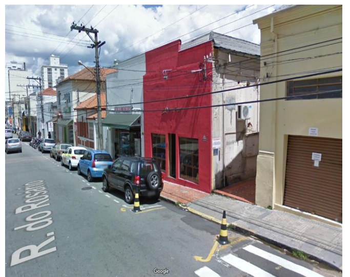
Aspecto da fachada do ano de 2010. Fonte: Google Street View – Foto: Março de 2010 – Acesso em 26/09/2019.
