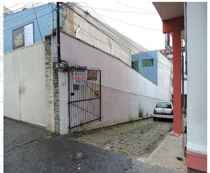
Aspecto recente da fachada do portão da Viela. Fonte: DPH – 26/09/2019.
