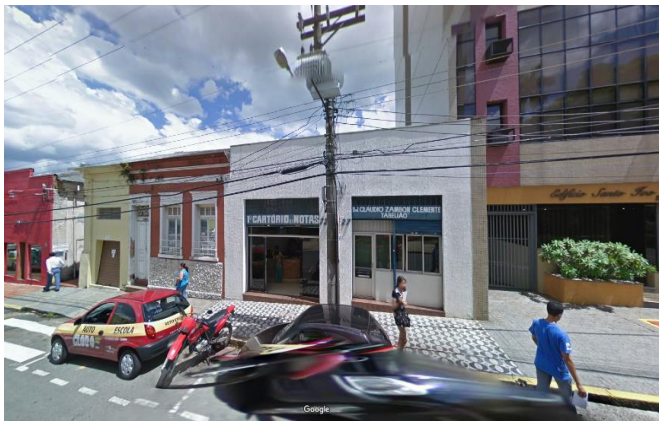
Aspecto da fachada do ano de 2010. Fonte: Google Street View Foto: março de 2010 – Acesso em 26/09/2019.
