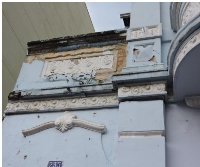
Figura 5: Acúmulo de crosta negra e descascamento da pintura, revelando a alvenaria estrutural. Fonte: Própria, 2016. Internamente, conserva-se no corredor da escada para o segundo pavimento uma moldura de teto em estuque cuja ornamentação remete aos motivos ecléticos da fachada frontal. Outros elementos foram eventualmente substituídos por exemplares mais contemporâneos conforme o uso original se perdeu.
