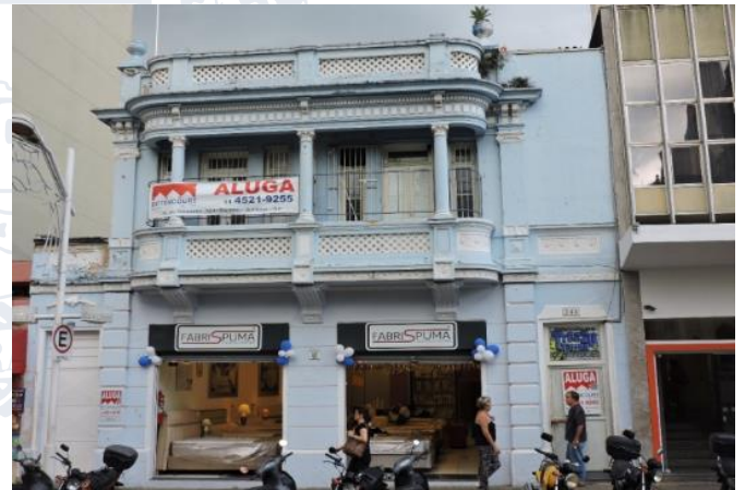
Figura 1: Fachada dos números 235, 239 e 243. Fonte: Própria, 2016.
