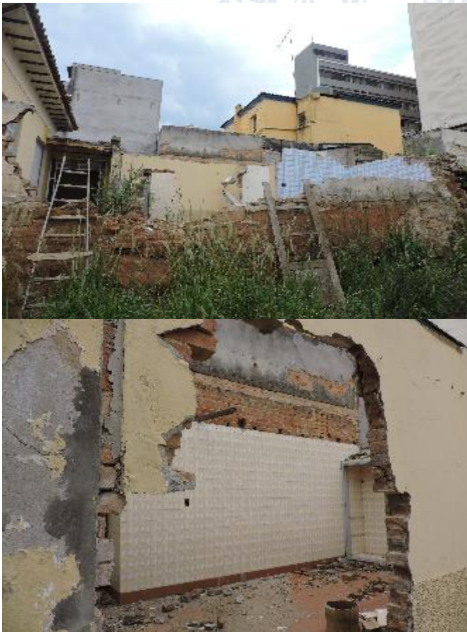
Figura 5: Demolição da edícula. Fonte: Própria, 2016.
