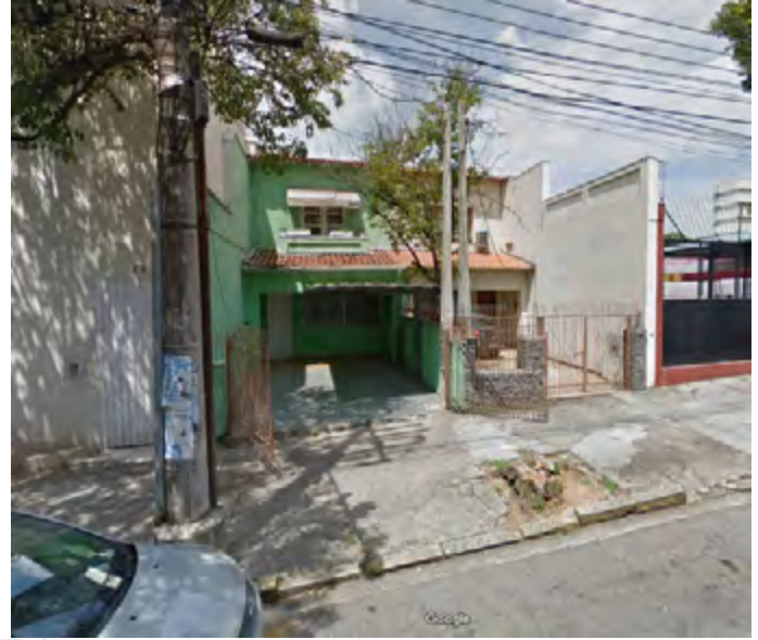
Aspecto da fachada da edificação anterior às modificações. Fonte: Google Street View – Foto: Janeiro de 2018 – acesso em 28/01/2020.
