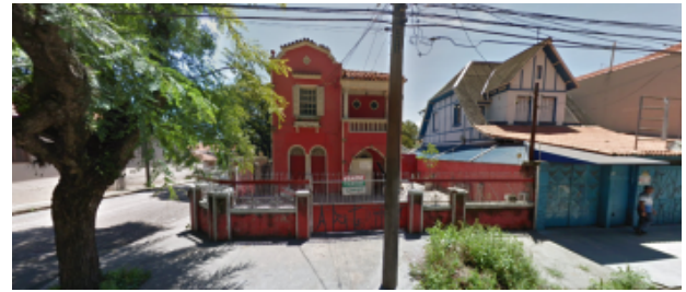
Figura 7. Aspecto recente da fachada da edificação. Fonte: Google Street View, Foto: Janeirode2018 – Acesso em 25/10/2019
