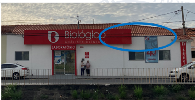
Na elipse em azul, detalhe da platibanda não executada. Foto: Elizeu Marcos Franco, 01.03.2021.
