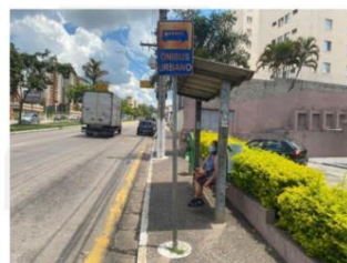
Foto 12. Ponto de parada de ônibus Fonte: SALLE CONSULTORIA E ENGENHARIA
