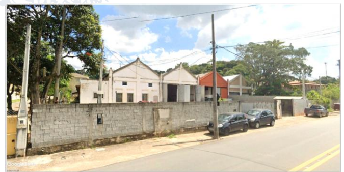
Figura 2: Fachada principal do imóvel - fonte: Google Earth, 03/2021
