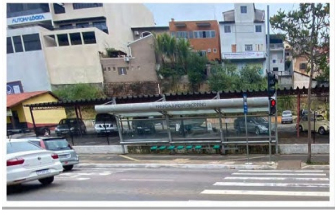
Foto 9: Ponto de parada de ônibus a ser remanejado Fonte: Salle Engenharia
