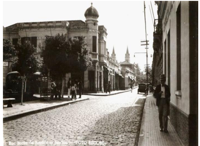
Fotografia 13 – Rua Barão de Jundiaí – próximo à Praça Ruy Barbosa - Centro
